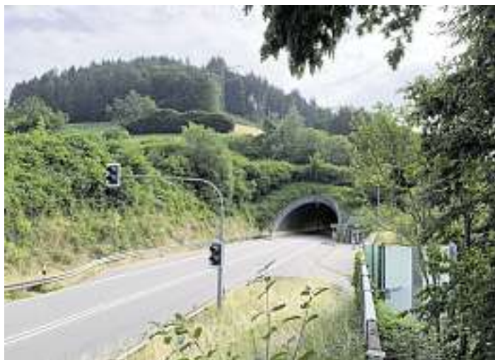
Sommerbergtunnel/ Quelle: Regierungspräsidium Freiburg
